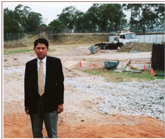
曾澤平先生在高齡宿舍建築工地上。
